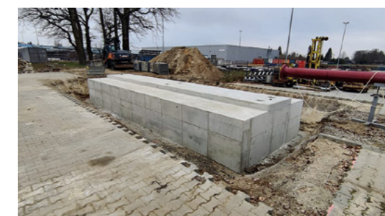
Abbildung 3: Neues Fundament der Gesteinskammer.
