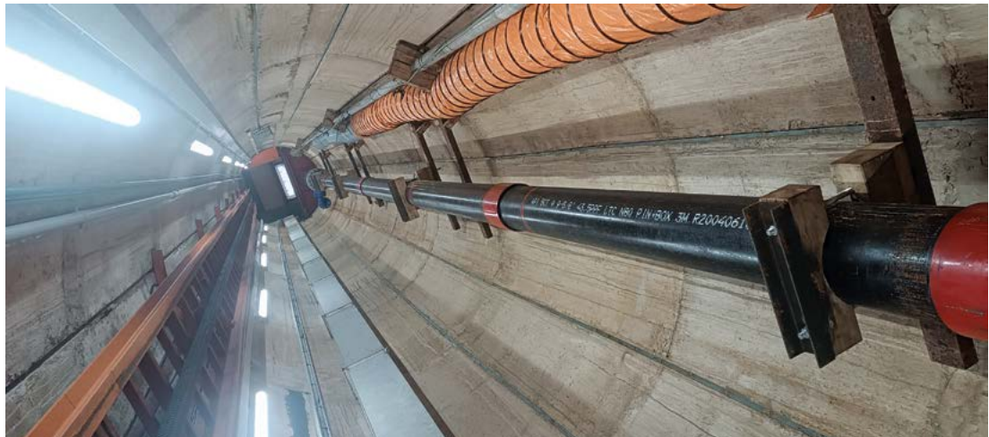
Abbildung 1: Schacht am ITE mit Blick auf den Einbau der geothermischen Sonde, aufgenommen aus rund 35 Metern Tiefe. Quelle: Jörg Riesen
